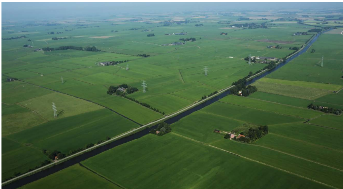
Luchtfoto kijkend op Middag Humsterland met de 110 kV en 220 kV op de achtergrond
