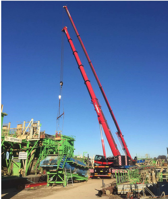
Demontage van "de Rotterdam" te Itteren
