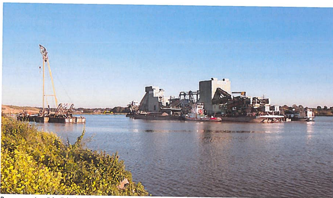
Baggermolen "de Friesland" te Bosscherveld
