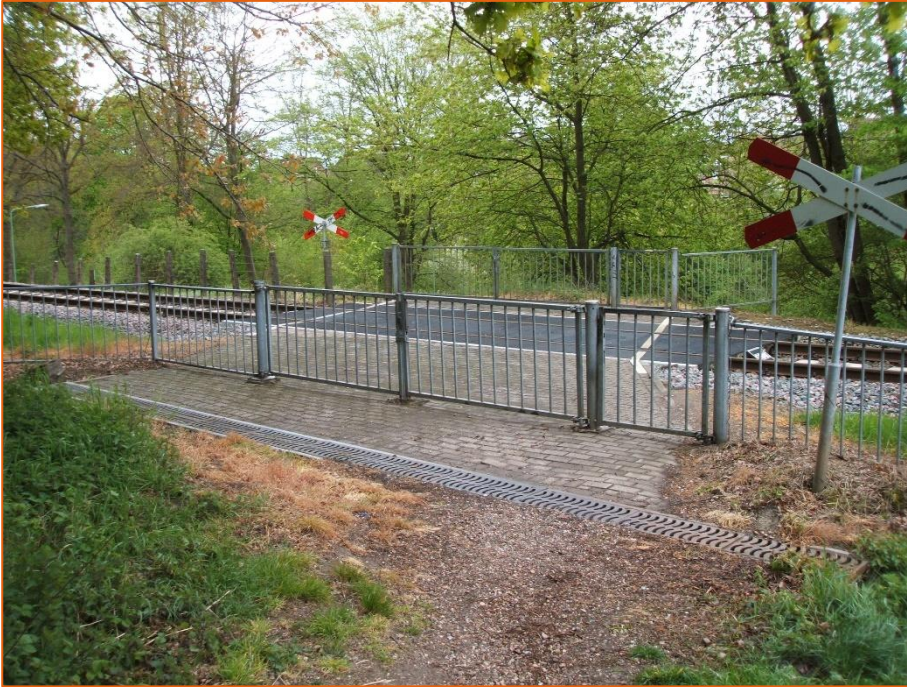
Afbeelding 3, overweg Schoufferbosweg, noordzijde.
