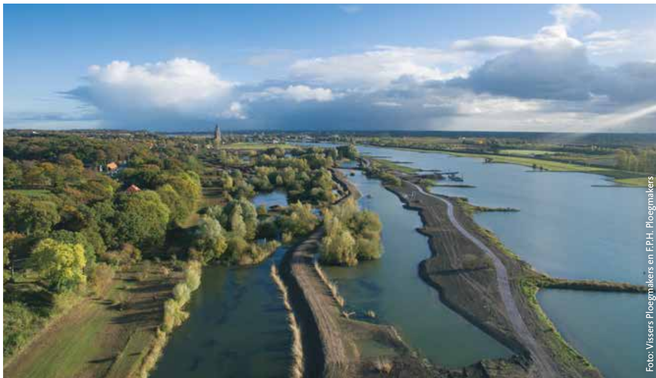
De Palmerswaard tijdens de graafwerkzaamheden eind 2016
