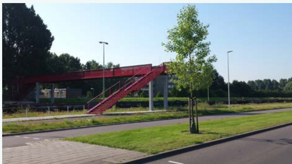
De Langzaamverkeersbrug Charlois scoort voldoende op het rijksdoel Ruimtelijke kwaliteit, maar voldoet niet geheel aan de projectambitie Verbinden van stad en water.
