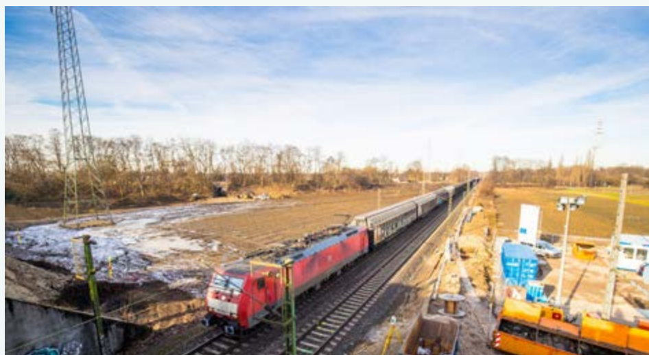
Met de aanleg van een derde spoor tussen Emmerich en Oberhausen wordt de Betuweroute nóg beter benut en is meer treinverkeer vanaf de haven mogelijk. (BRON: PRORAIL)
