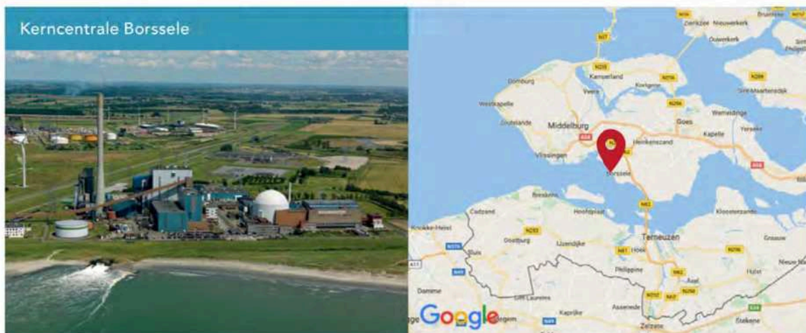
Figuur 4: Kerncentrale Borssele. (Bron linkerfoto: EPZ)
