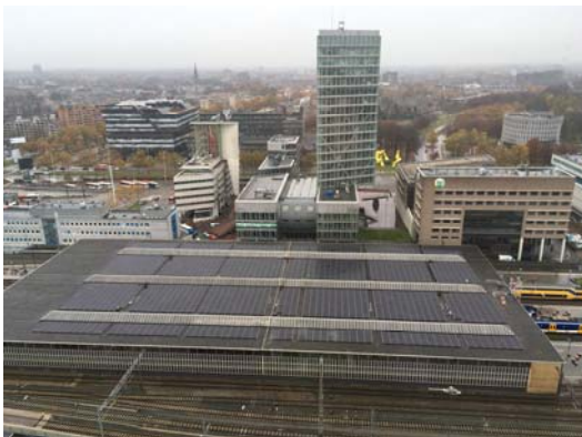
1.900 zonnepanelen op de monumentale perronoverkapping van station Eindhoven
