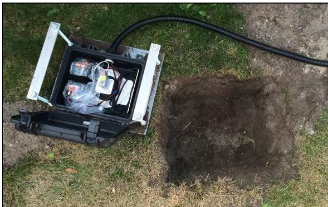
Figuur 2.2: Aanbrengen trillingsmeter in de bodem
