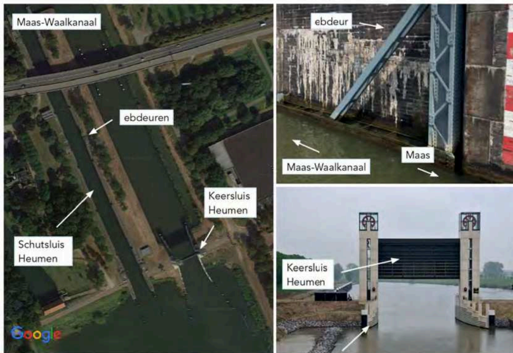
Figuur 1: Boveenaanzicht sluis Heumen (links), keersluis Heumen (rechtsonder), ebdeuren in schutsluis (rechtsboven). Bron: Rijkswaterstaat
