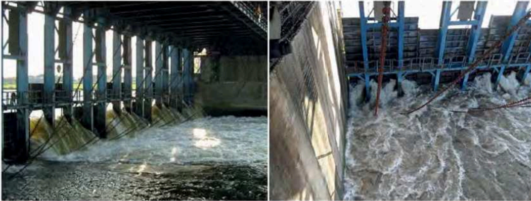
Figuur 4: Stuw Grave gezien vanaf de benedenstroomse zijde bij lage afvoer van circa 150-200 m 3 /s (links) en bij hoge afvoer van circa 1300 m 3 /s (rechts). (Bron: Rijkswaterstaat)
