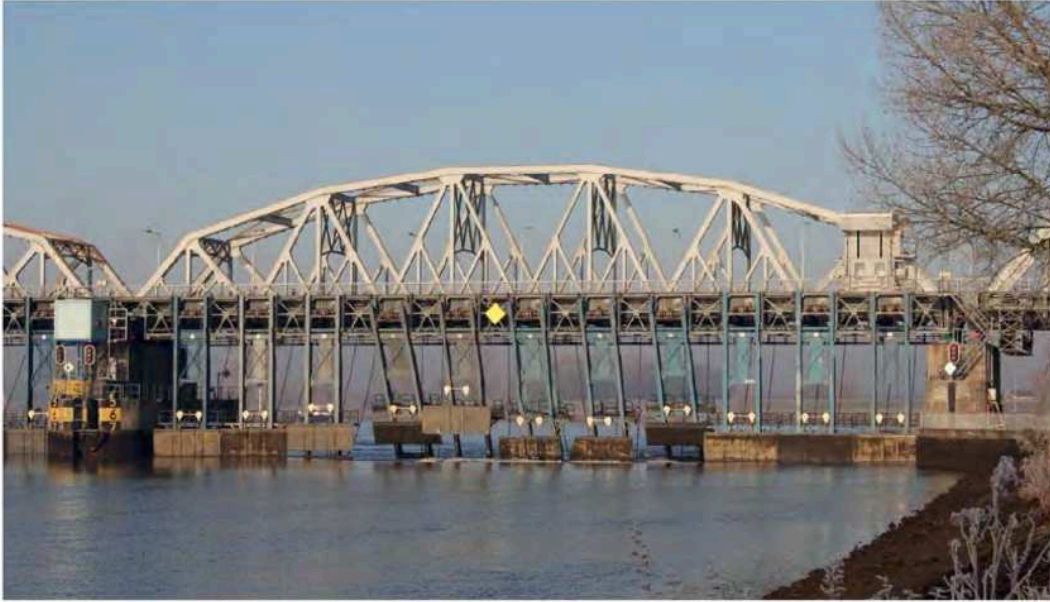
Figuur 12: Gele ruit op brug boven stuw.
