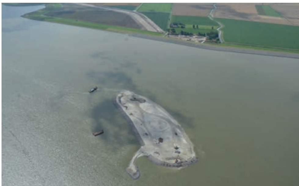
Aanleg van het vogelbroedeiland in de Eems-Dollard (foto: Luchtsurveillance Rijkswaterstaat Noord).
