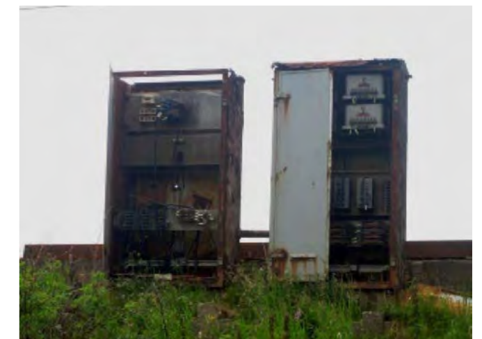
Afgedankte meterkasten met hoge concentraties polychloorbifenylen (PCB's)
