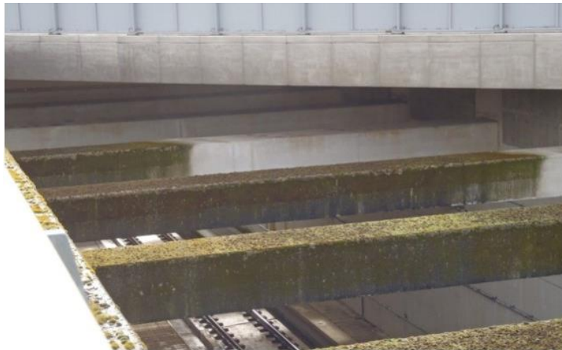
Figuur 5.3: Geen mosgroei op delen van stempel onder viaduct (foto B.16 in [02])
