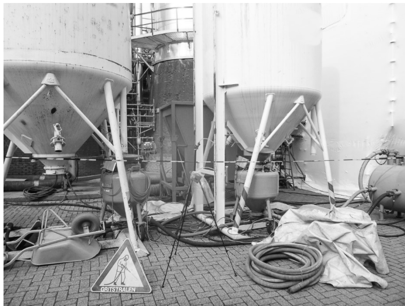
Meetlocatie 1B: Overzichtsfoto van opstellen tijdens vullen (links vullen vanuit vulsilo, rechts vullen vanuit zakken, positie stationair meetpunt, en positie straaltent ten opzichte van vulwerkzaamheden
