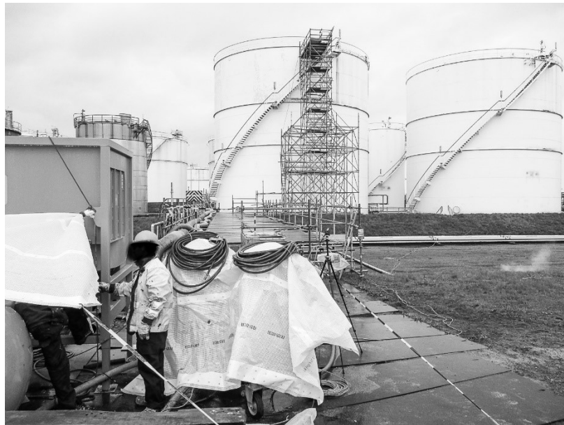
Meetlocatie 1C: Overzichtsfoto, met vulopstelling op de voorgrond en tank waarin wordt gestraald op de achtergrond in het midden
