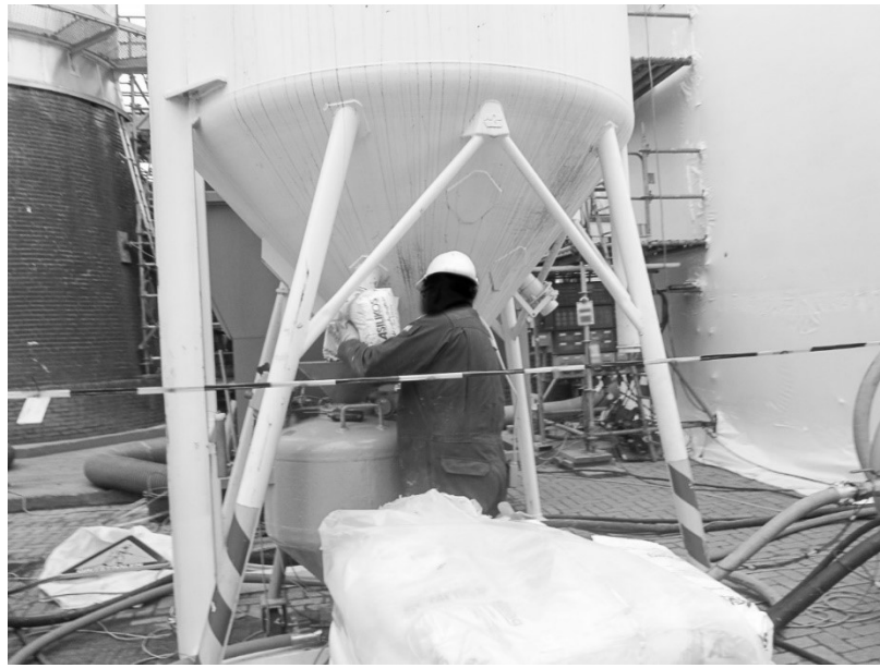
Meetlocatie 1B: Vullen van de straalketel met zakken
