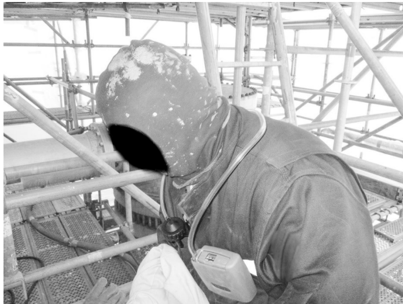
Meetlocatie 1B: Voorbereiding persoonlijke meting onder de straalkap bij straler
