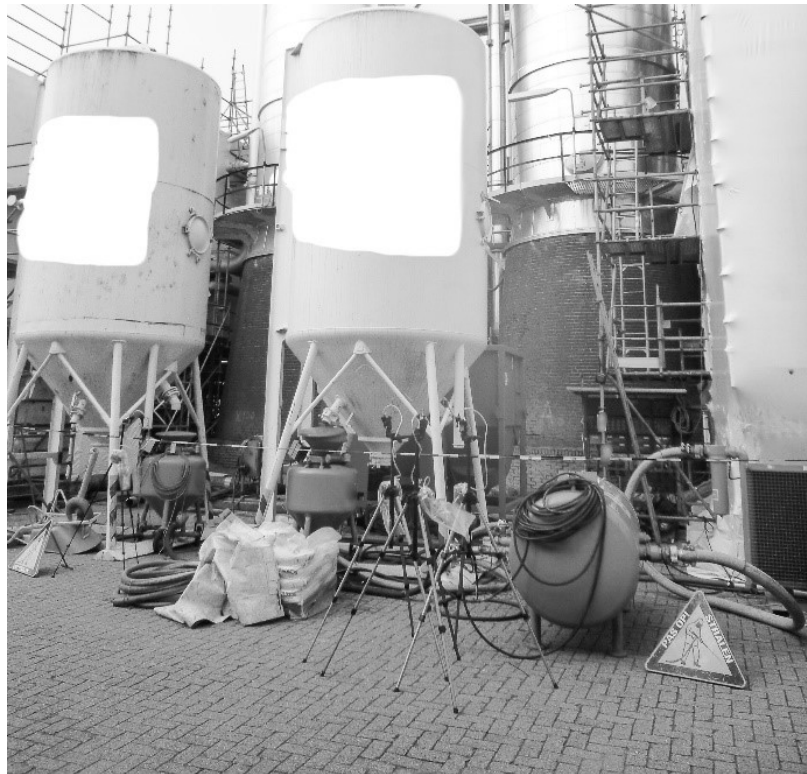
Meetlocatie 1B: Overzichtsfoto van opstellen tijdens vullen (links vullen vanuit vulsilo, rechts vullen vanuit zakken, positie stationair meetpunt, en positie straaltent ten opzichte van vulwerkzaamheden
