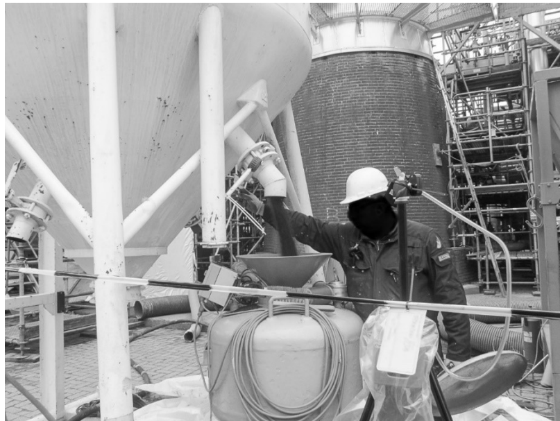
Meetlocatie 1B: Vullen van straalketel vanuit de vulsilo, handmatige bediening
