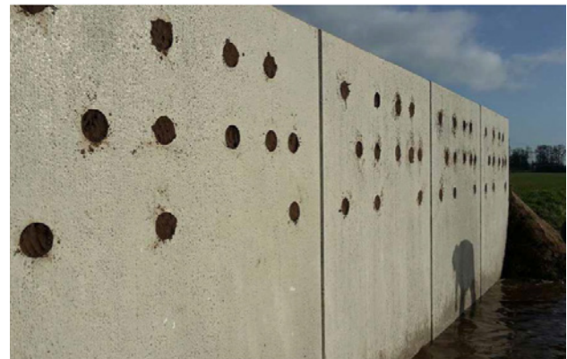
Oeverwaluwand op bedrijventerrein Hessenpoort
