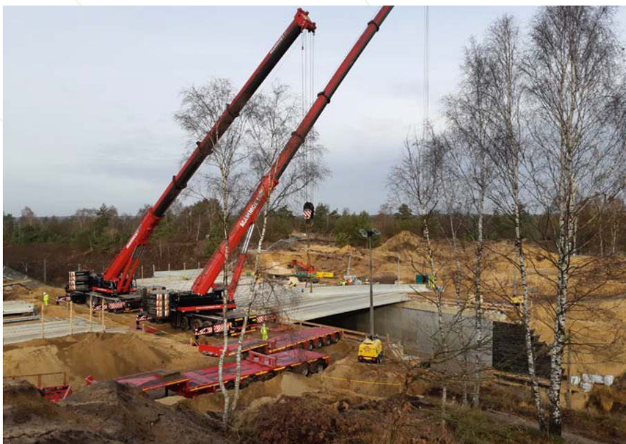
Plaatsen liggers bij natuurbrug Asselsche Heide.
