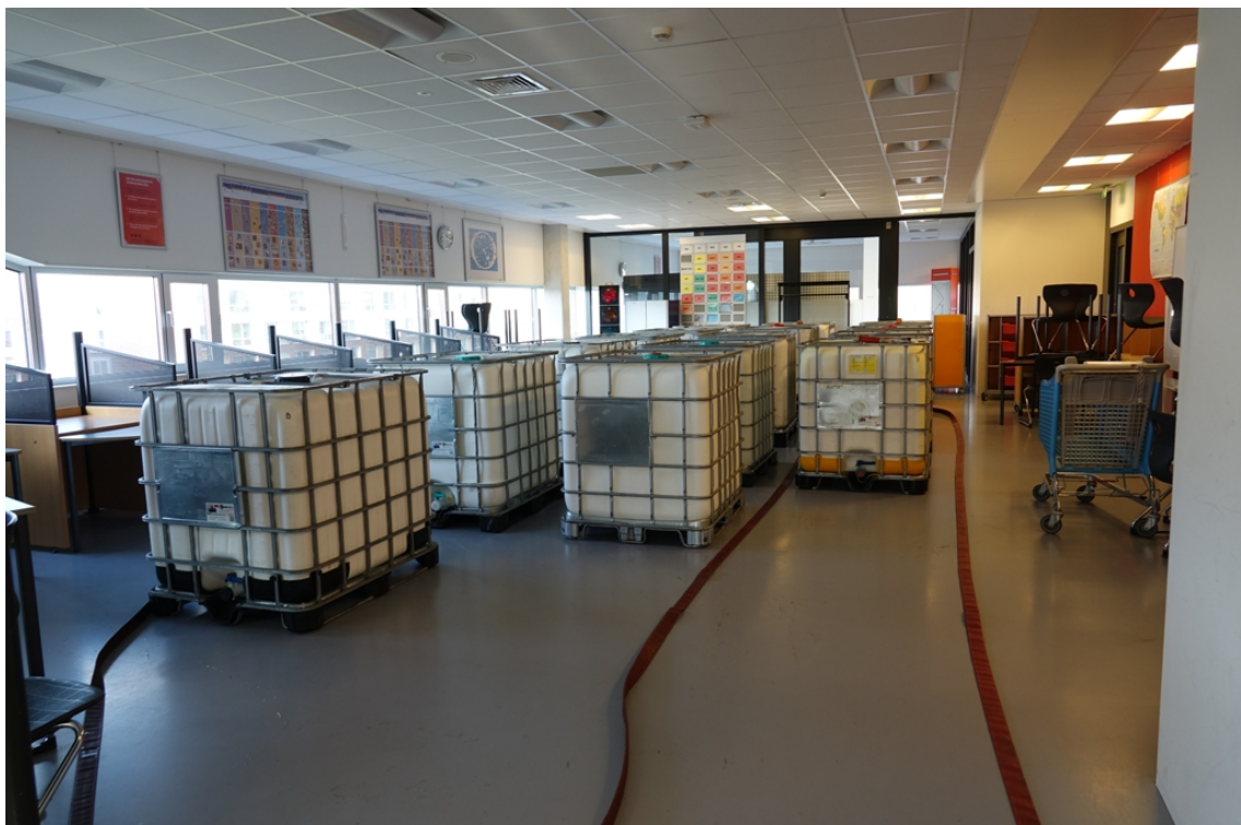
foto G-1 Voorbeeld van uitvoering van proefbelasting met water.
