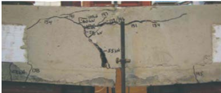
foto 9 Bezwijkbeeld proefstuk 6 (met tralieligger naast de naad) [24]
