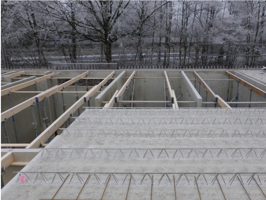
foto 2 Breedplaten geplaatst op jukkan voor het storten van de druklaag, bron: https://www.nbd-online.nl/product/132146-breedplaatvloeren-van-olbecon
