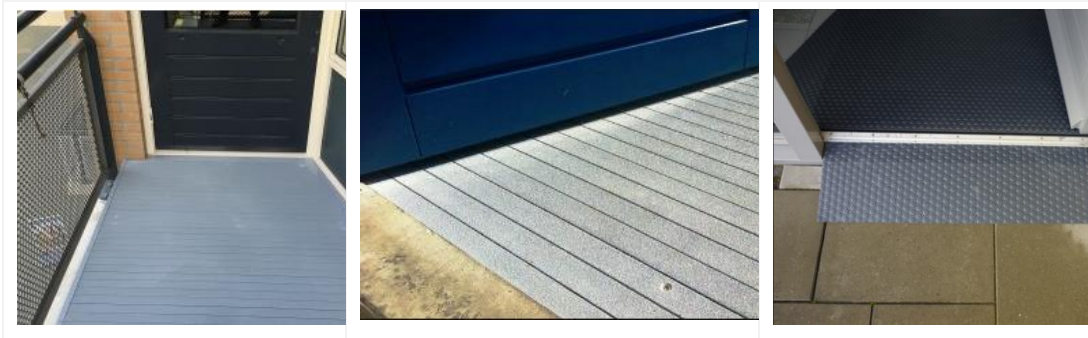
figuur 4-8 voorbeelden ophoging balkon
