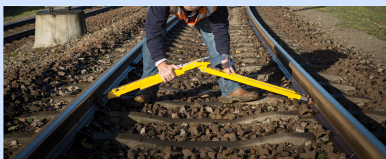
Foto 3: Plaatsen van een kortsluitlans door een medewerker van Strukton.
