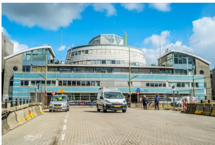
figuur 6-2 Studentenwoningen aan de Phoenixstraat in Delft
