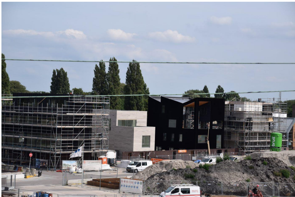
BOUW WONINGEN IN HET AMSTELKWARTIER IN AMSTERDAM
