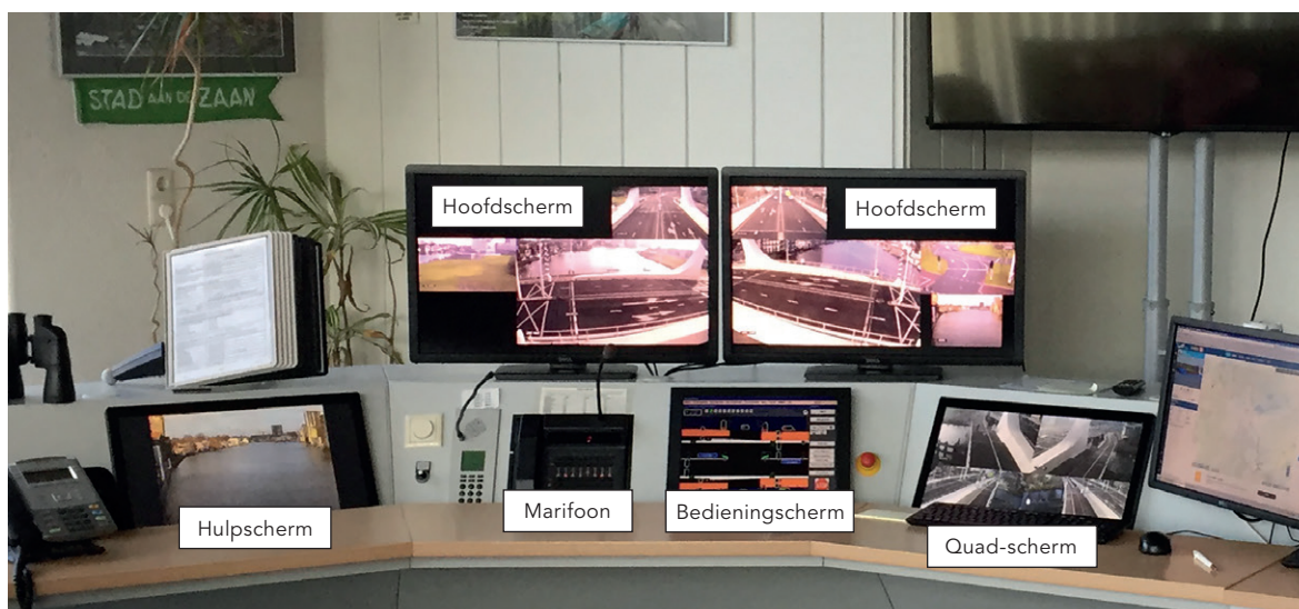
Figuur 5: Opstelling bedieningspaneel; de schermen op de centrale post in december 2018. (Bron: Onderzoeksraad voor Veiligheid)
