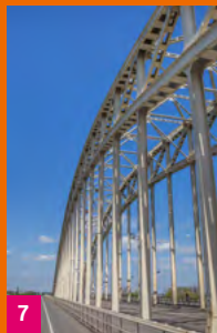
7 The Waal bridge in Nijmegen. (p 22)
