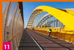
11 Bicycle path and footpath on the Hogeweidebrug or Yellow Bridge over the Amsterdam-Rijnkanaal in Utrecht. (p 24)
