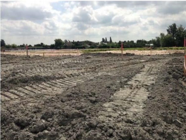
Figuur 2.3 Noordse Leem in een terreinophoging (Roelofarendsveen)
