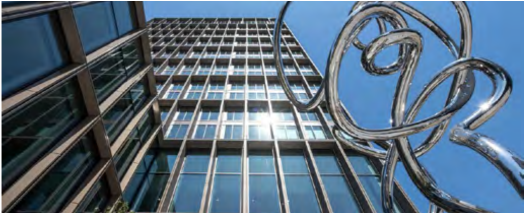
EMA gebouw in Amsterdam (Bron: Rijksvastgoedbedrijf . Foto: Corné Bastiaansen)
