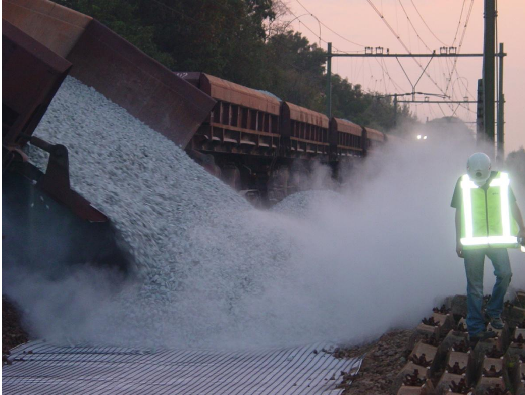
Foto 1.6: Stofontwikkeling bij het lossen van de Fassen ballastrein
