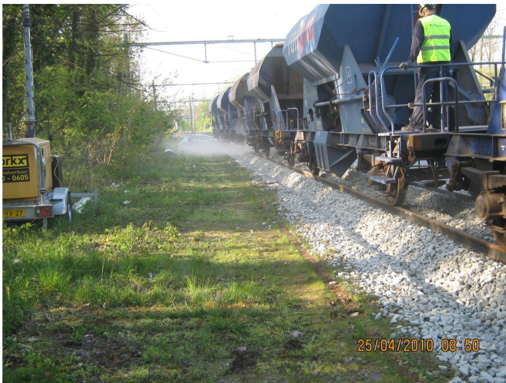
Foto 3.2: Lossers aan het werk op een FCCPP ballasttrein.
