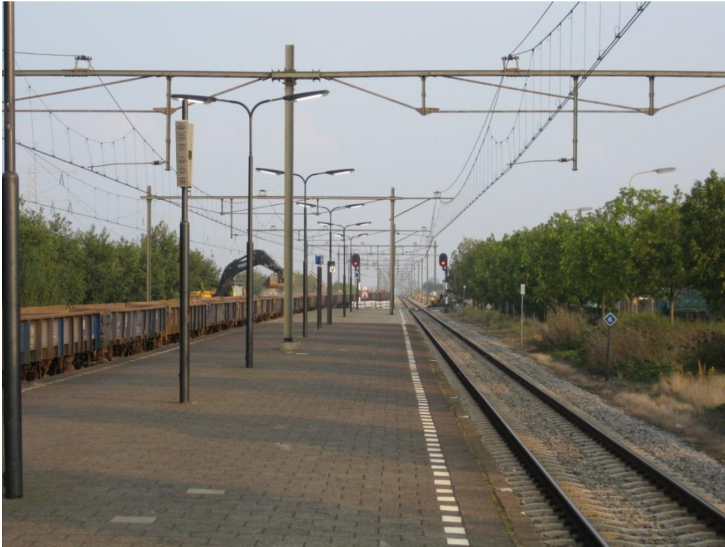
Foto 1.2: Graafmachine op het station Kruiningen-Yrseke
