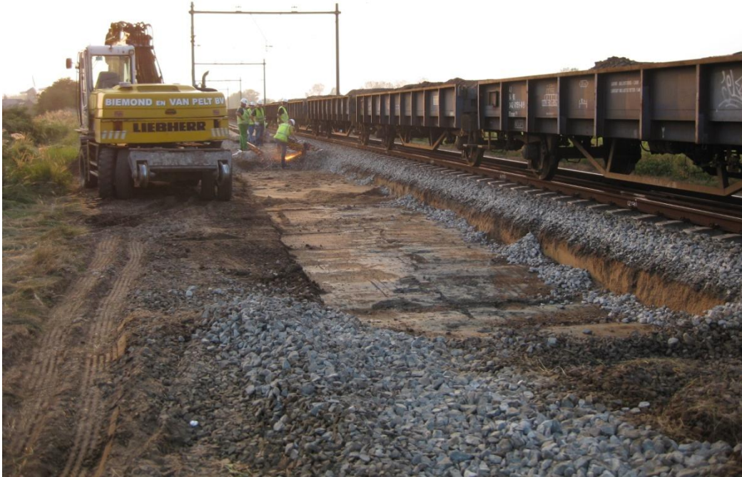
Foto 1.4: Werkzaamheden bij Eindewegen
