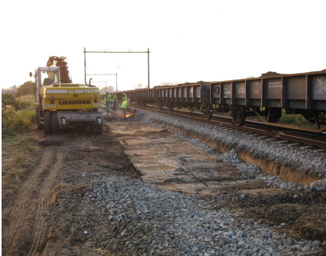
Foto 1.4: Werkzaamheden bij Eindewegen
