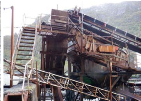
Eikefet: 2 wassers, nadere inspectie niet mogelijk
