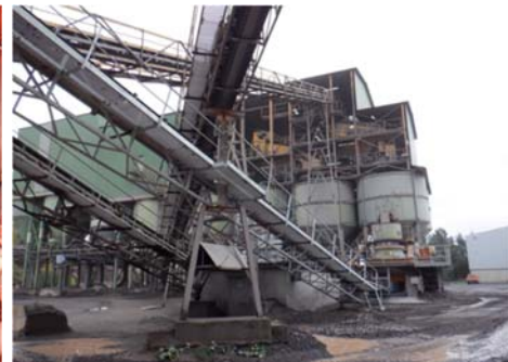
Werk-Nickenich: installatie, nadere inspectie niet mogelijk
