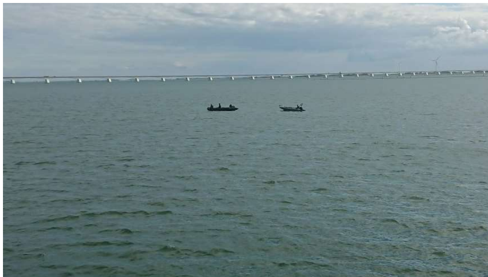
Figuur 5 Duikwerkzaamheden vanaf rubberboten.
