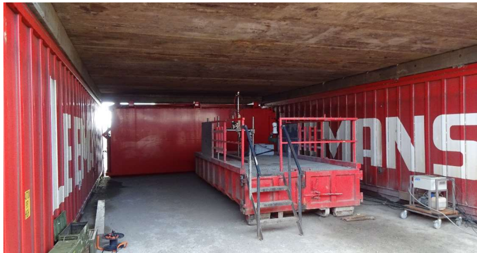
Figuur 8 Opstelling voor waterstraalsnijder, afgeschermd met containers gevuld met zand.
