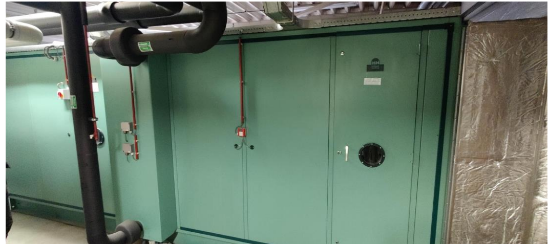
Figuur 5: Luchtbehandelingskast 1
