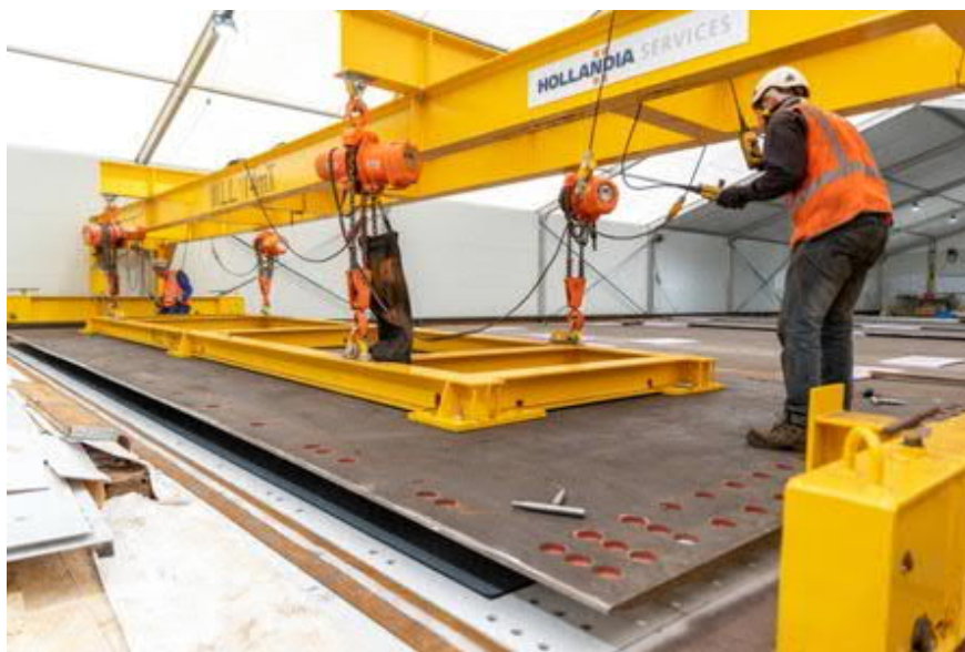
Figuur 9.2: Plaatsing van nieuwe dekplaten op de bestaande dekplaten
