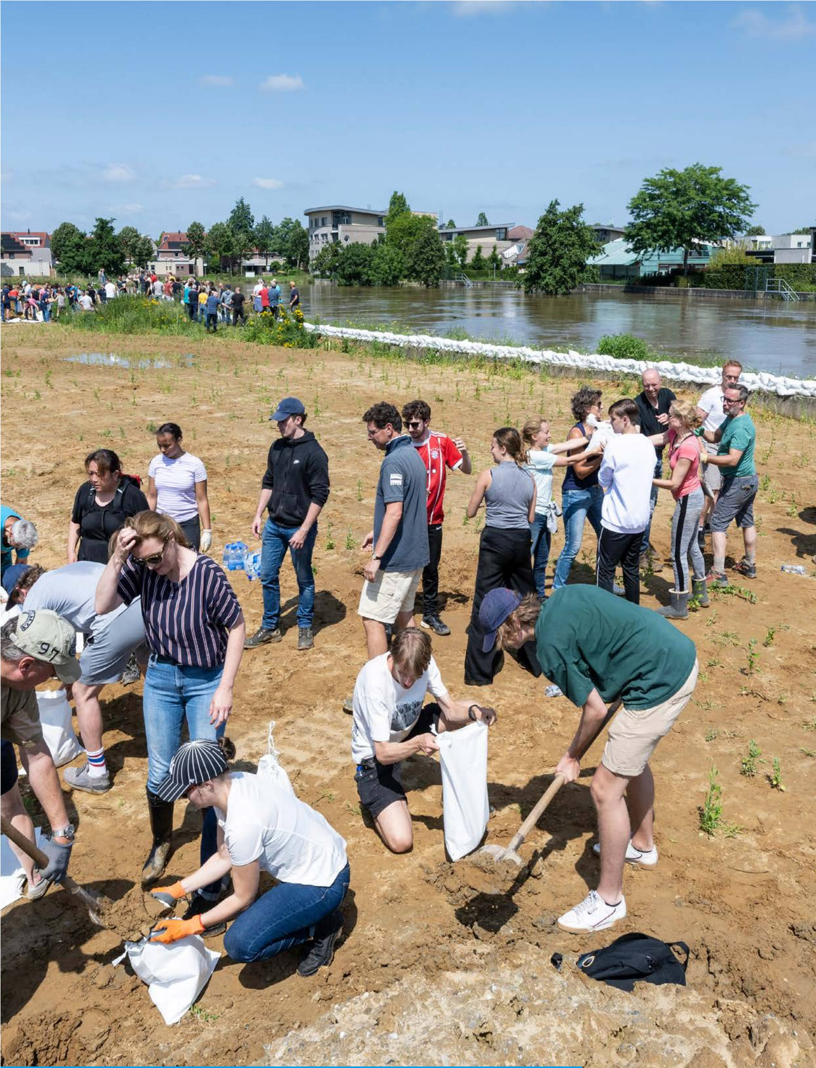
Rivier de Roer bij Roermond, juli 2021. Zandzakken zijn gelegd op het dijkje langs de Roer voor de splitsing met de Hambeek om achtergelegen woonwijken te beschermen tegen het stijgende hoge water, vloedgolf uit Duitsland.
