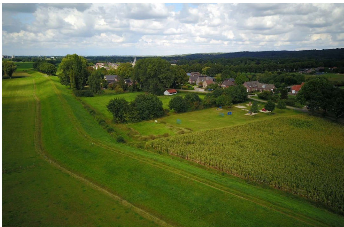
Afbeelding 12: De huidige dijk bij Middelaar in het Maasdal is aangelegd na het hoogwater van 1995
