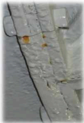
Ijzercement tussen de flenzen
