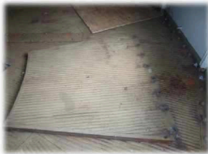
Vloerplaat 9A, uitgenomen
