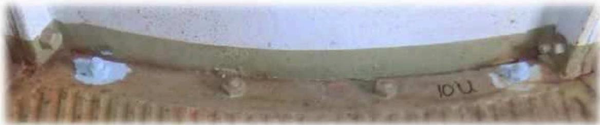
Status vloerplaat 10U op 21 juni 2011
