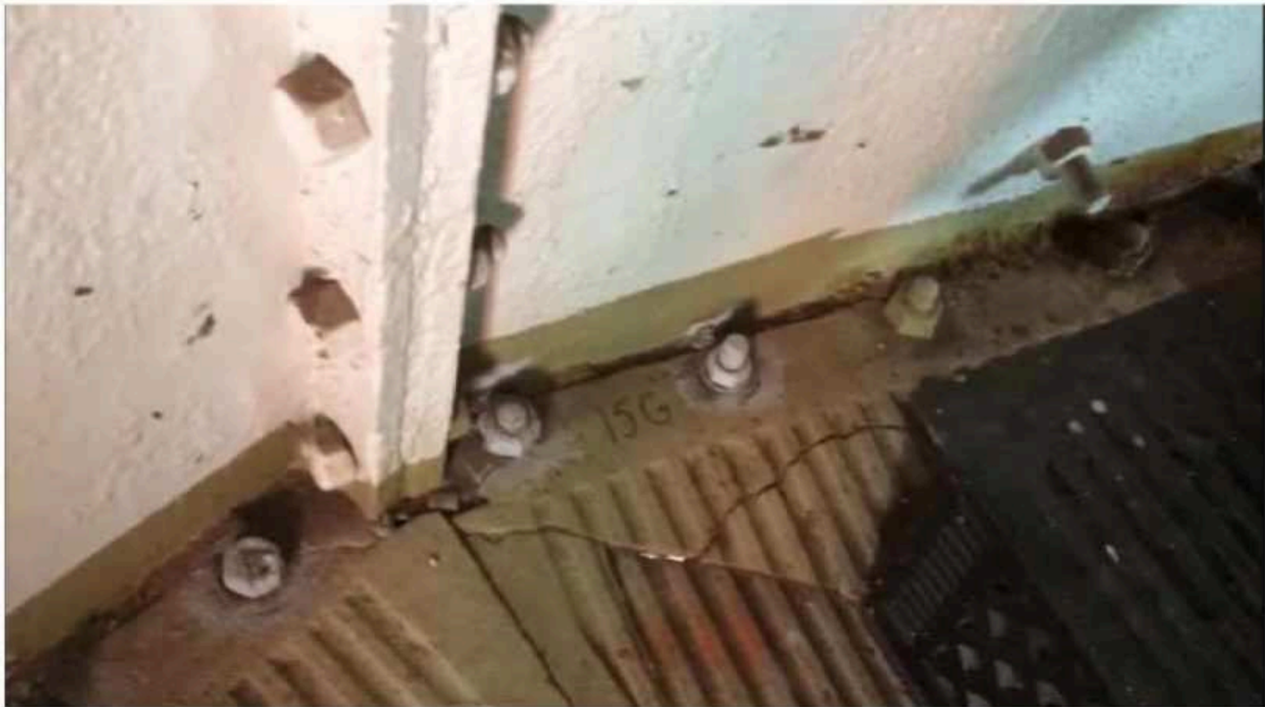
Figuur 6: bezweken vloer op niveau 15 nabij transportroute
