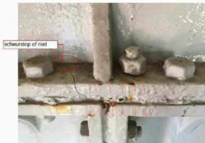
Scheur in de lip van het wandpaneel (ref. 2, 2019)
