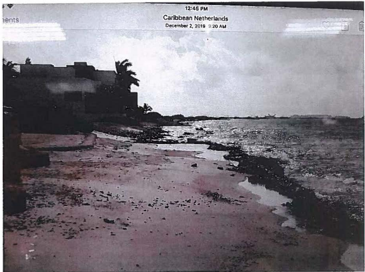
Op de foto met datum en tijdstip duidelijk te zien een keermuur van rotsen in het marinepark, immers zeker geen 15 meter van de hoogwaterlijn. Percelen 4-H-315 en 4-H-316. De Senior-inspectuer [redacted] [redacted]
