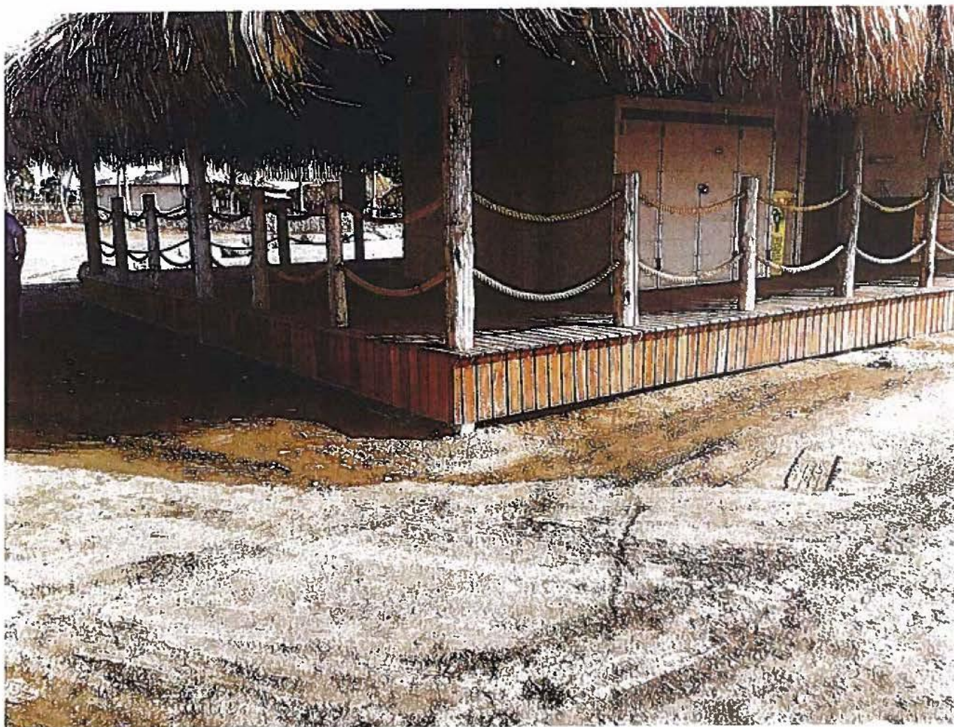
Foto toont duikschool gebouw van dichterbij aan. Duidelijk te zien dat de container is bekleed met houten planken.
