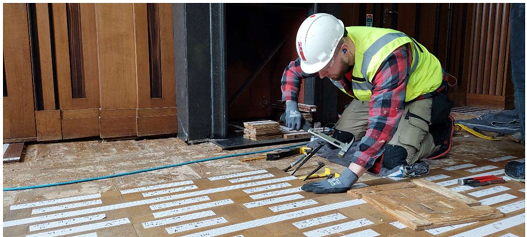
Werkzaamheden vloer Raadzaal, Michiel Hartkamp
