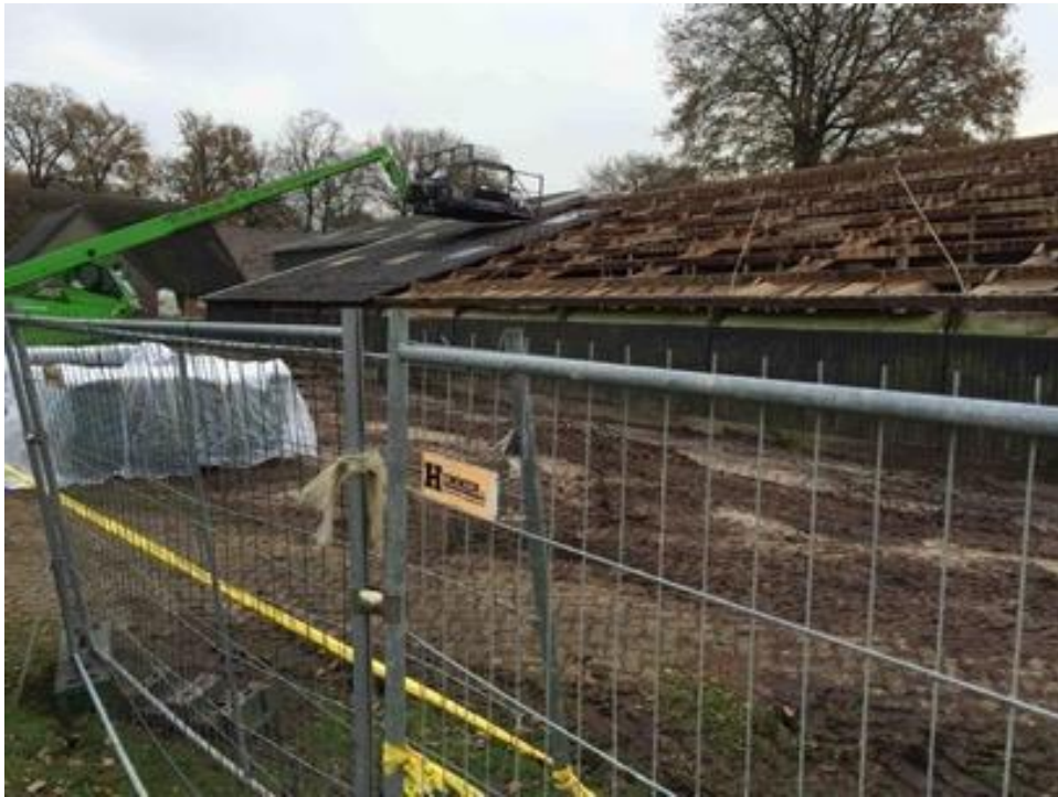
Foto: Saneren van een asbestdak
