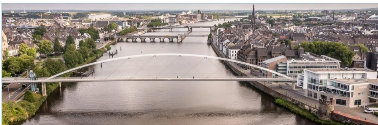
Figuur 3-1 De Hoge Brug in Maastricht
