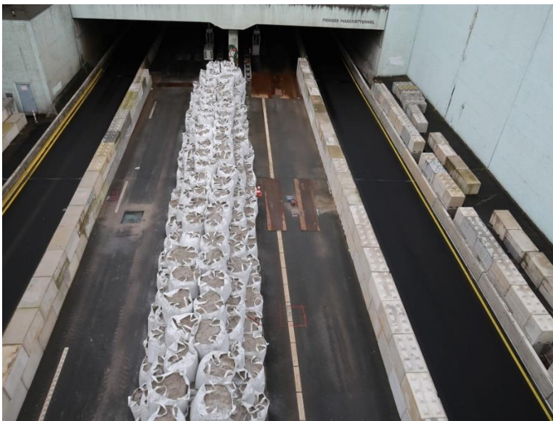
Figuur 3.8 Situatie ten tijde van het onderzoek – toerit zuid (deel nabij tunnel).
