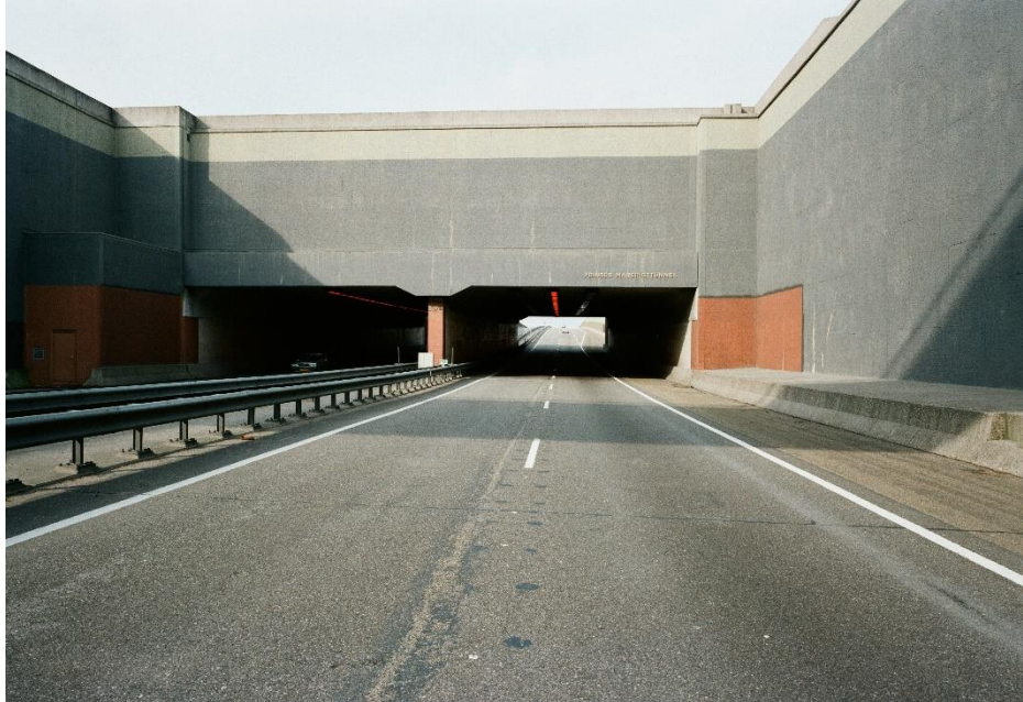
Figuur 3.1 Overzicht van de zuidzijde van de tunnel (foto Beeldbank RWS).
