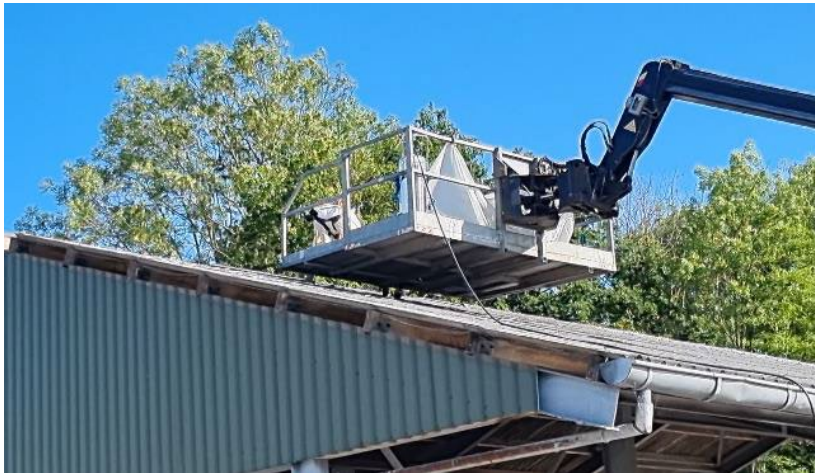
Foto 14: Oppakken asbestcement golfplaat vanuit verreiker
