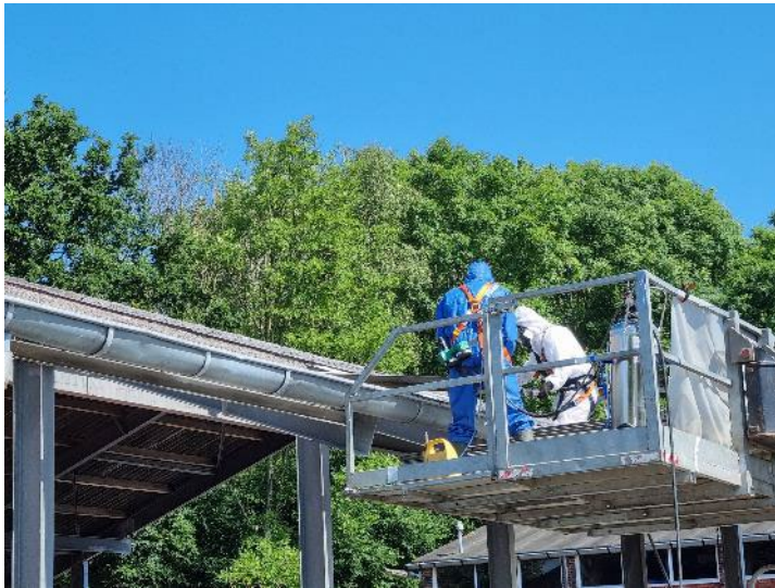
Foto 23: Plaatsen (schuiven) asbestcement golfplaat in de bak van de verreiker
