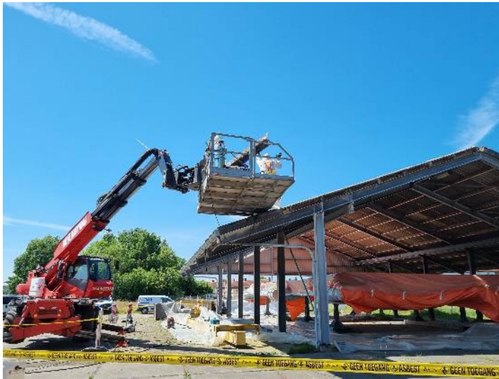
Foto 27: Plaatsen verwijderde asbestcement golfplaat (nokstuk) in de bak van de verreiker
