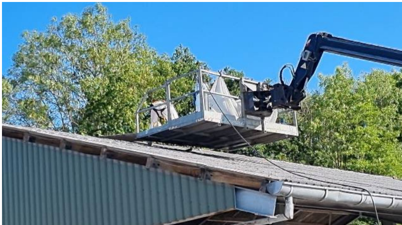
Foto 15: Verplaatsen (schuiven) asbestcement golfplaat naar bak verreiker
