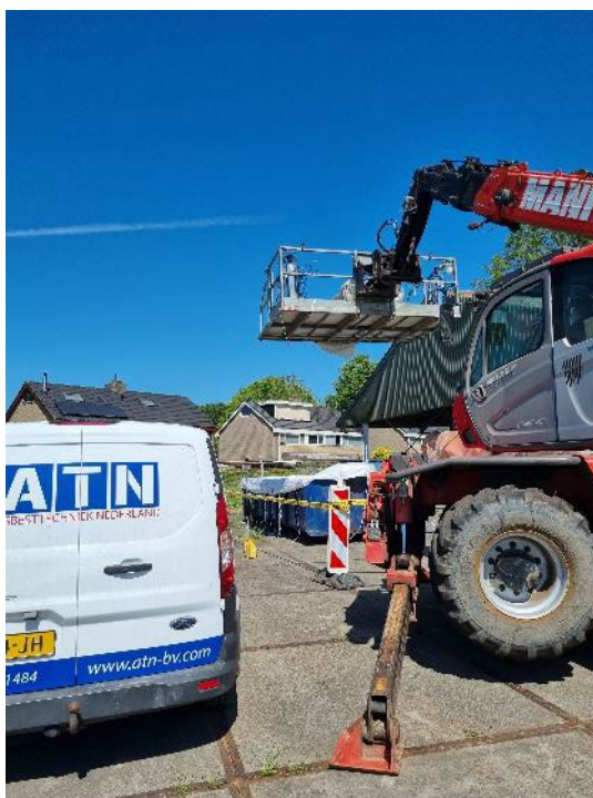
Foto 24: Verplaatsen ingepakte asbestcement golfplaten met de verreiker naar de afvalcontainer
