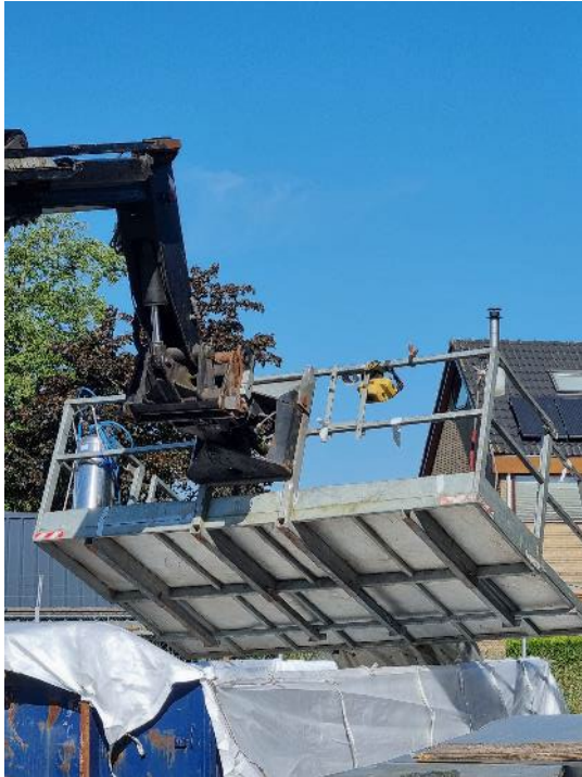
Foto 19: Ingepakte asbestcement golfplaten vanuit de bak van de verreiker in de afvalcontainer plaatsen
