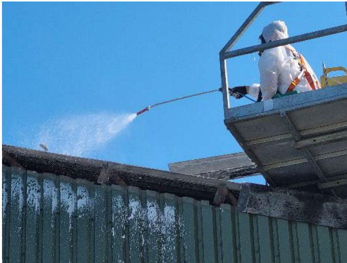
Foto 9: Bijschuimen terwijl nokstuk aan de zijkant in de bak van de verreiker wordt geplaatst
