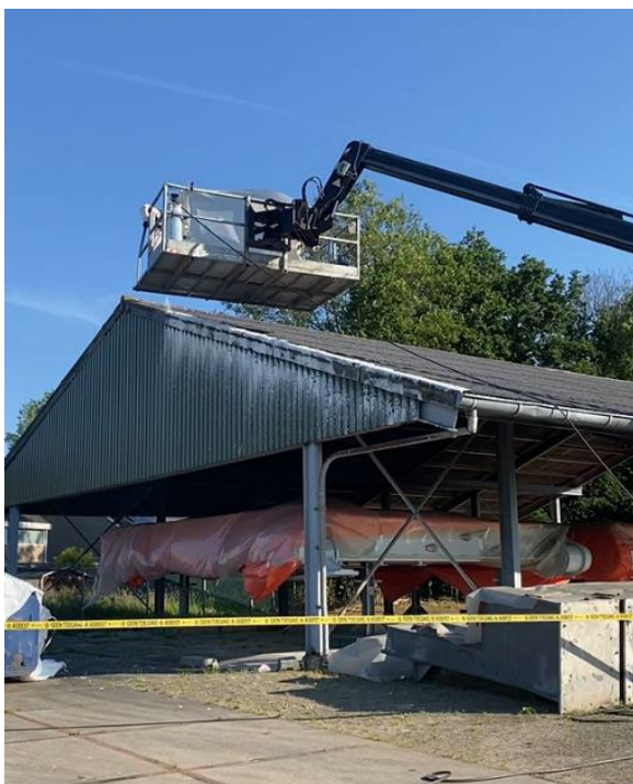
Foto 6: Inschuimen van de asbestcement golfplaten (nokstukken zijkant) op de verreiker
