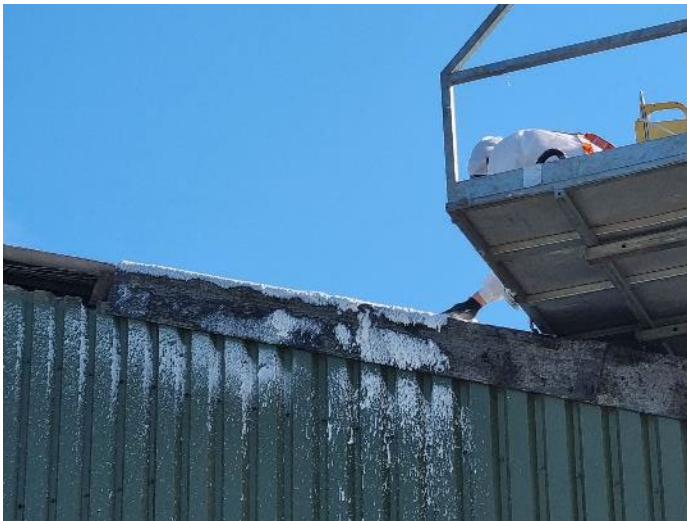
Foto 8: Verwijderen ingeschuimd nokstuk aan de zijkant
