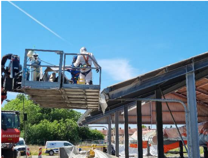
Foto 31: Plaatsen nokstuk in de bak van de verreiker
