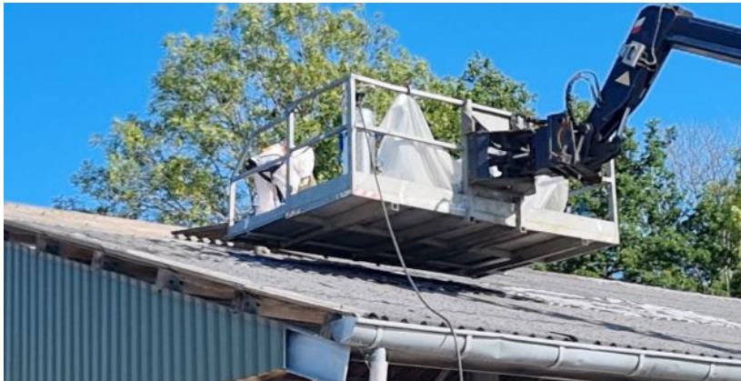
Foto 17: Verplaatsen (schuiven) asbestcement golfplaat naar bak verreicher
