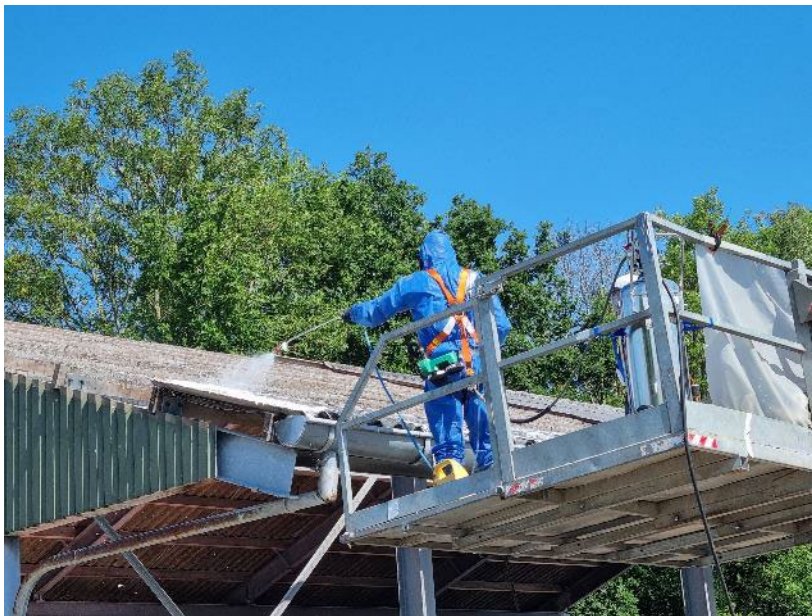
Foto 22: Inschuimen asbestdak vanuit verreiker
