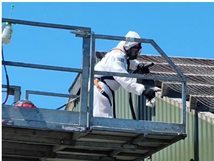
Foto 39: Schoonmaakwerkzaamheden zijkant dak, stofzuigen en afnemen met een natte doek
