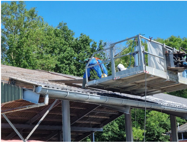
Foto 21: Plaatsen (schuiven) asbestcement golfplaat in de bak van de verreiker
