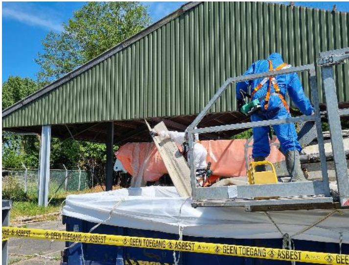
Foto 33: Verplaatsen verwijderde nokstuk van de bak van de verreiker naar de afvalcontainer
