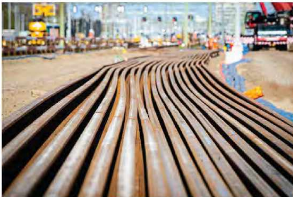
Werkzaamheden t.b.v. uitbreiding van sporen bij Zwolle.
