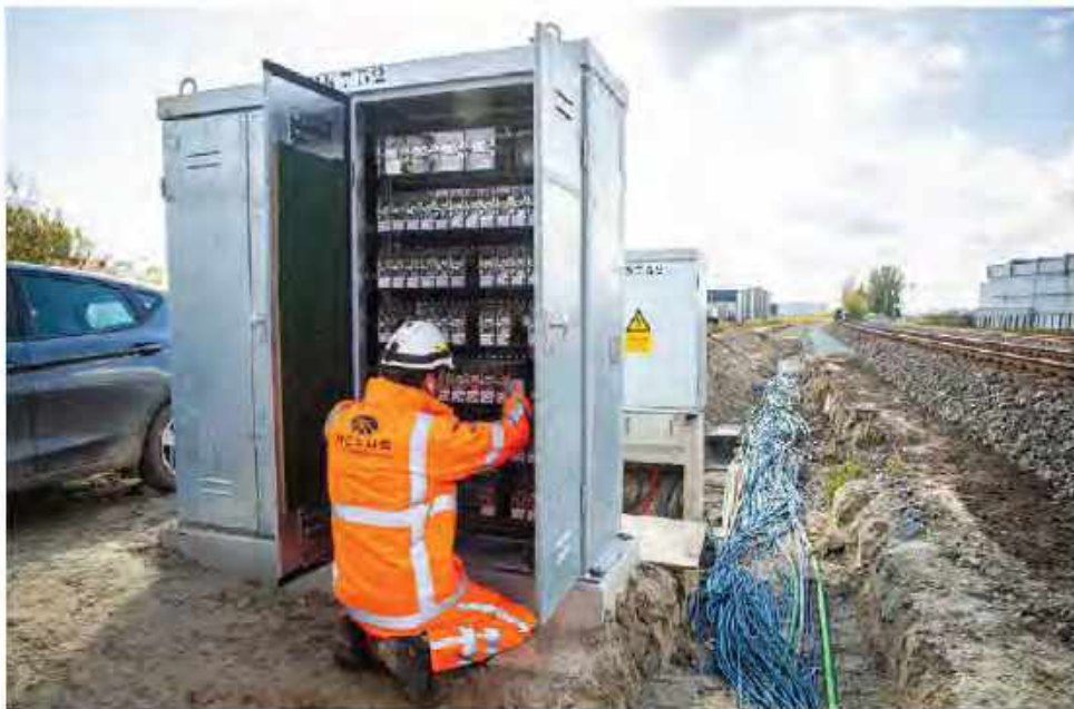
Werkzaamheden aan een relaiskast tussen Groningen en Buitenpost.
