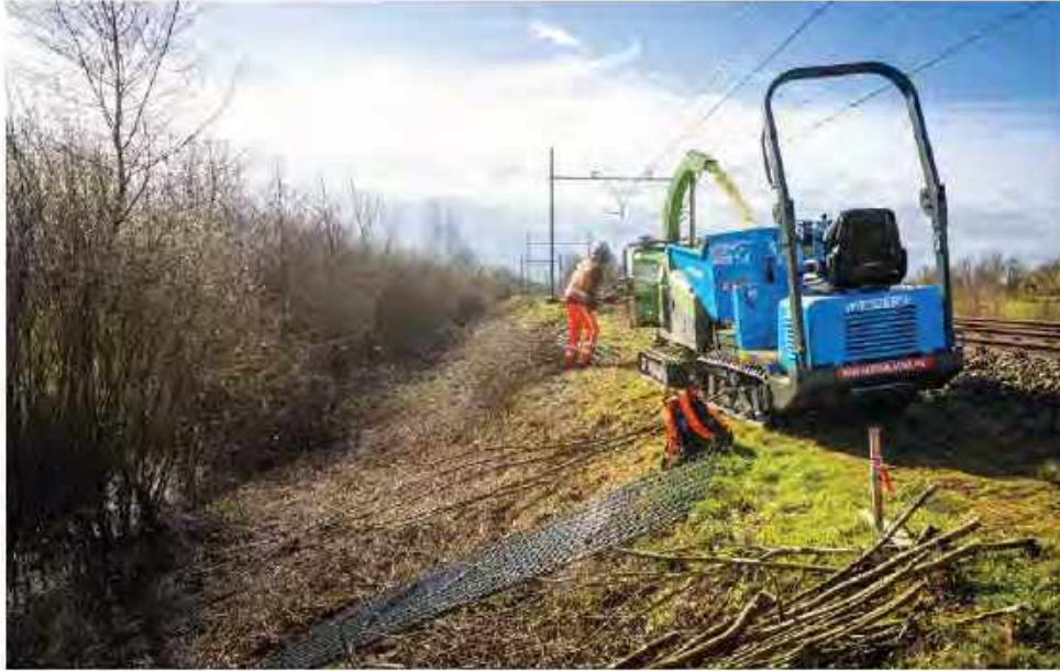
Verwijderen van dassenburchten onder het spoor bij Esch.
