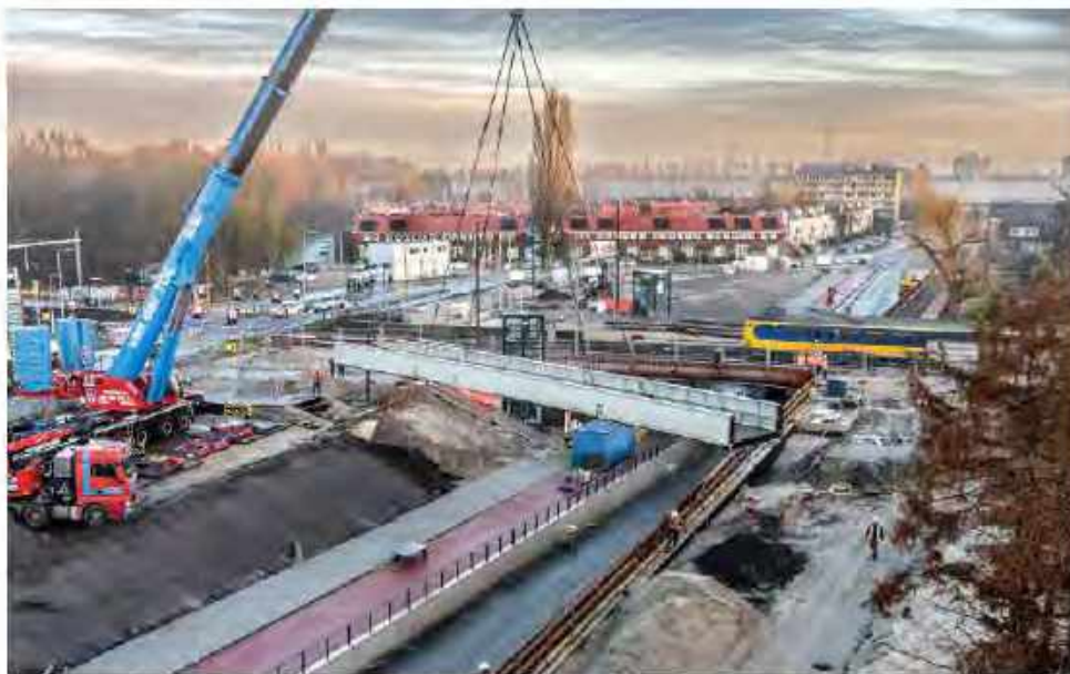
Wegtakelen van tijdelijke spoorbrug bij station Diemen.
