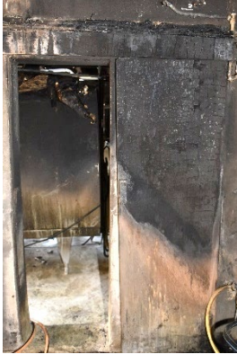
Afbeelding 10: Deurconstructie vanuit technische ruimte naar het tanklokaal.
