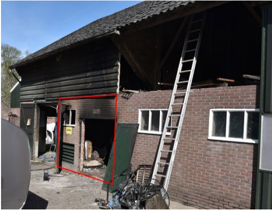
Afbeelding 13: Mogelijk traject brandoverslag vanuit de gevelopeningen.
