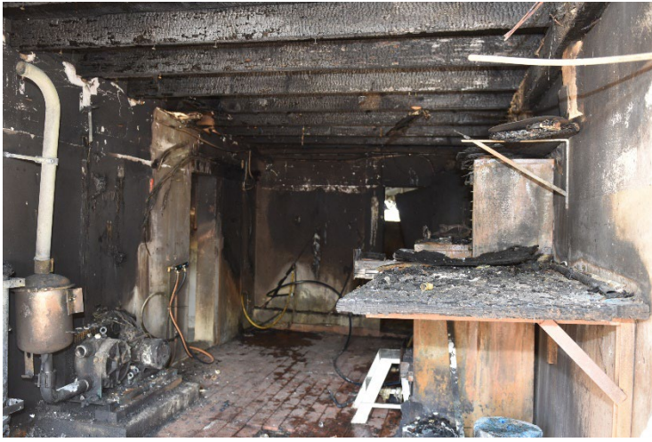
Afbeelding 5: Technische ruimte gezien vanaf de deuropening
