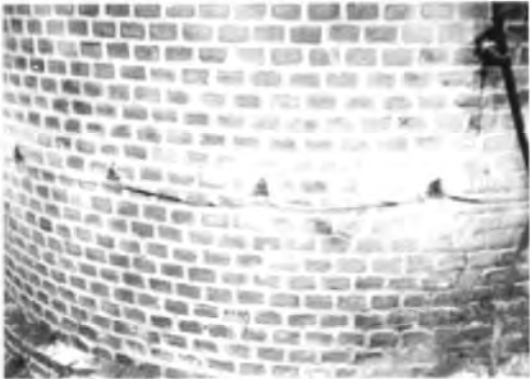
Het gebruik van explosie-ven bij het slopen van bouwwerken
