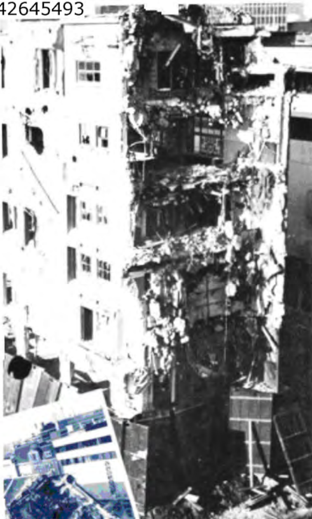
Beelden van het springen met explosieven van de laatste gedeelten van het Haagse Courant-gebouw
