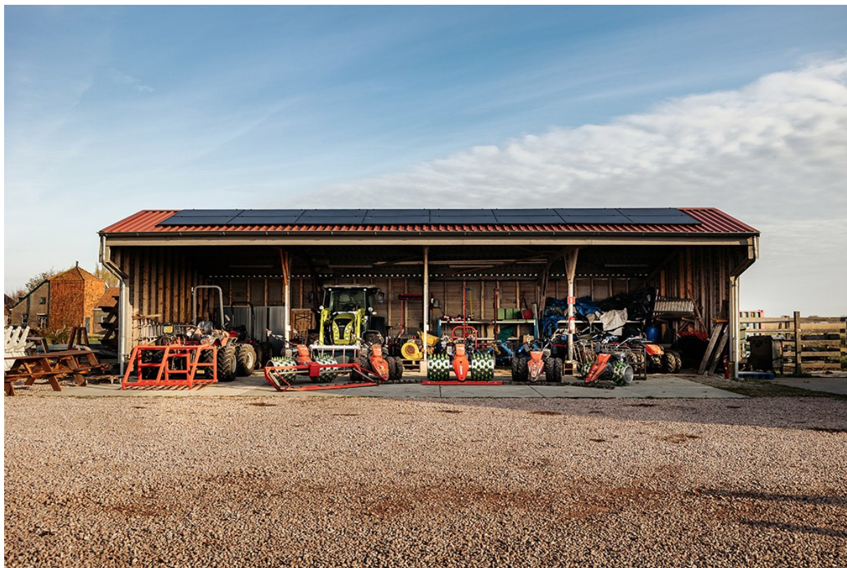
Werklocatie Veenweiden gebied met zonnepanelen op de kapschuur
