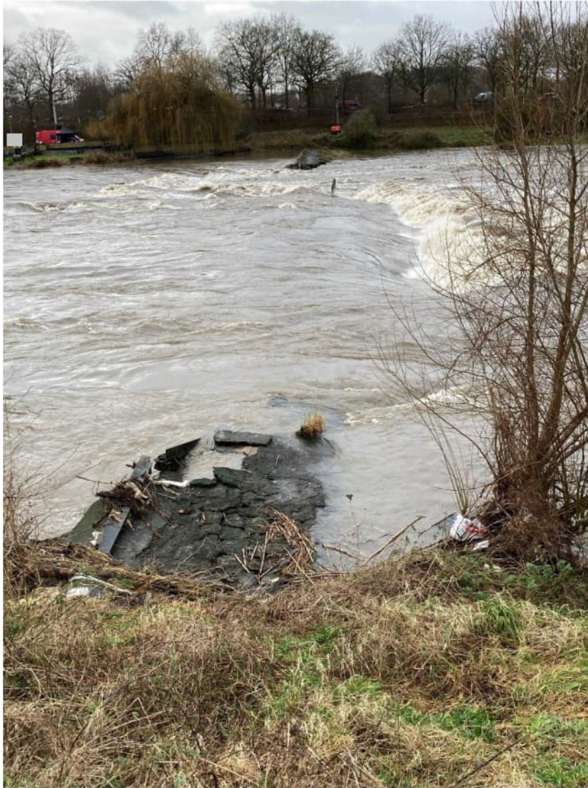
Figuur 4.13 Groot deel van de overlaat is sterk verlaagd.
