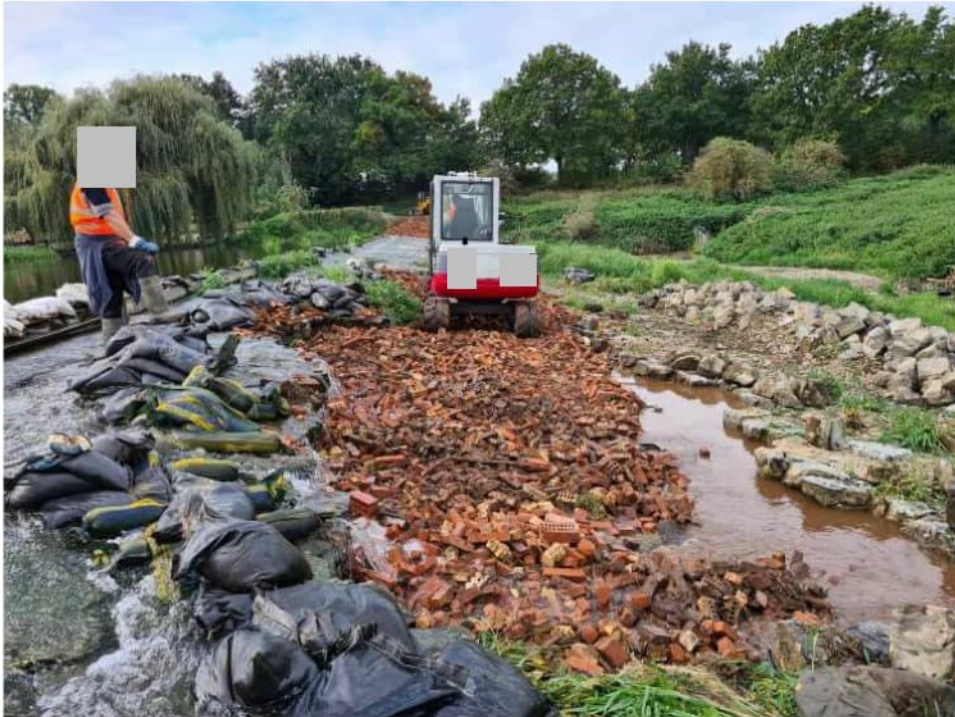
Figuur 4.7 Aanbrengen vlijlaag van puin.
