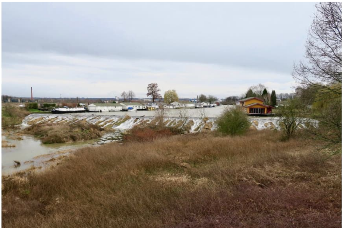
Figuur 2.11 Foto van de overlaat op 13 februari 2020.
