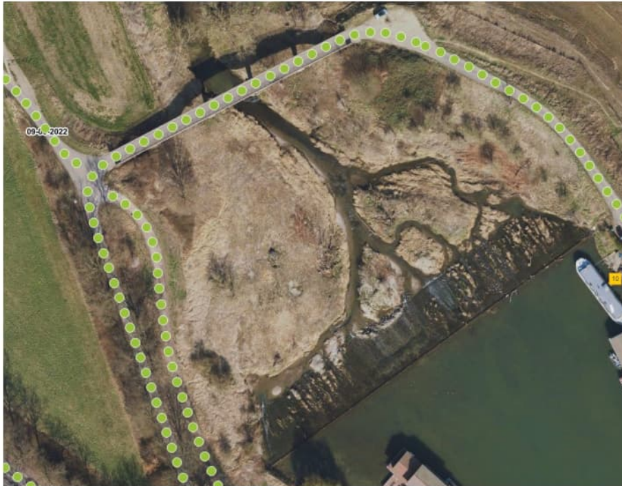
Figuur A.9 Luchtfoto 09-03-2022.
