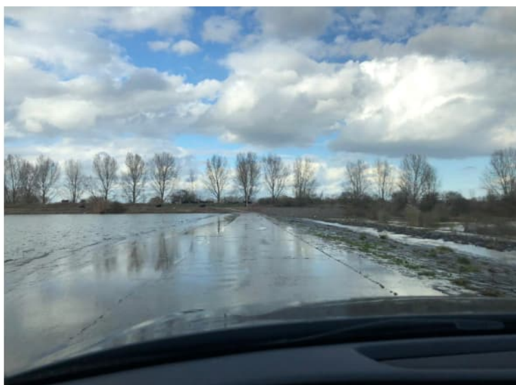
Figuur 6.7 Foto van de overlaat Linne in 2020 (stroming van links naar rechts).
