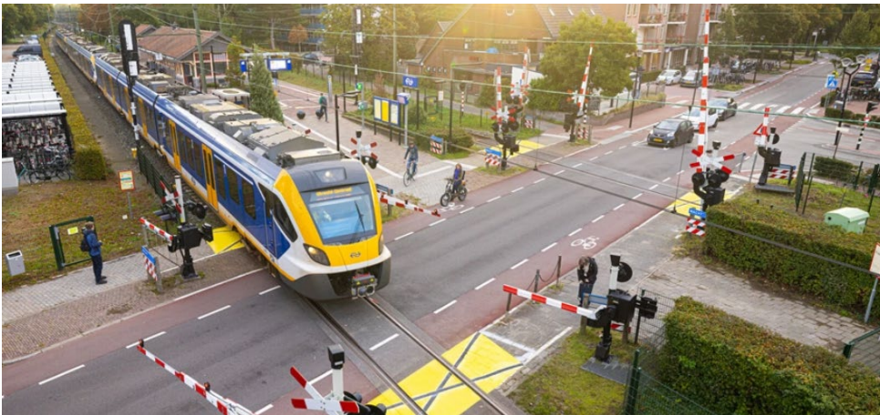
In HY1 zijn vier overwegen voorzien van gele vlakken met zwarte kruizen (bron: prorail.nl)
