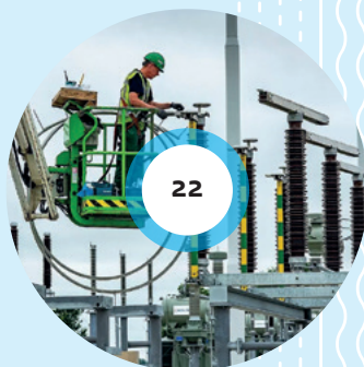
380 kV-netuitbreiding Noord-Holland Noord
